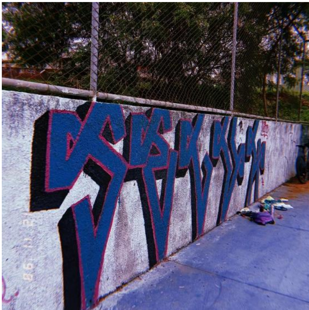
FIGURA 63: SELVA – GRAPIXO SOB MURO
