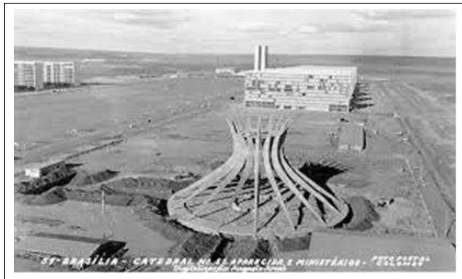
Figura 49 – Construção da cidade de Brasília
