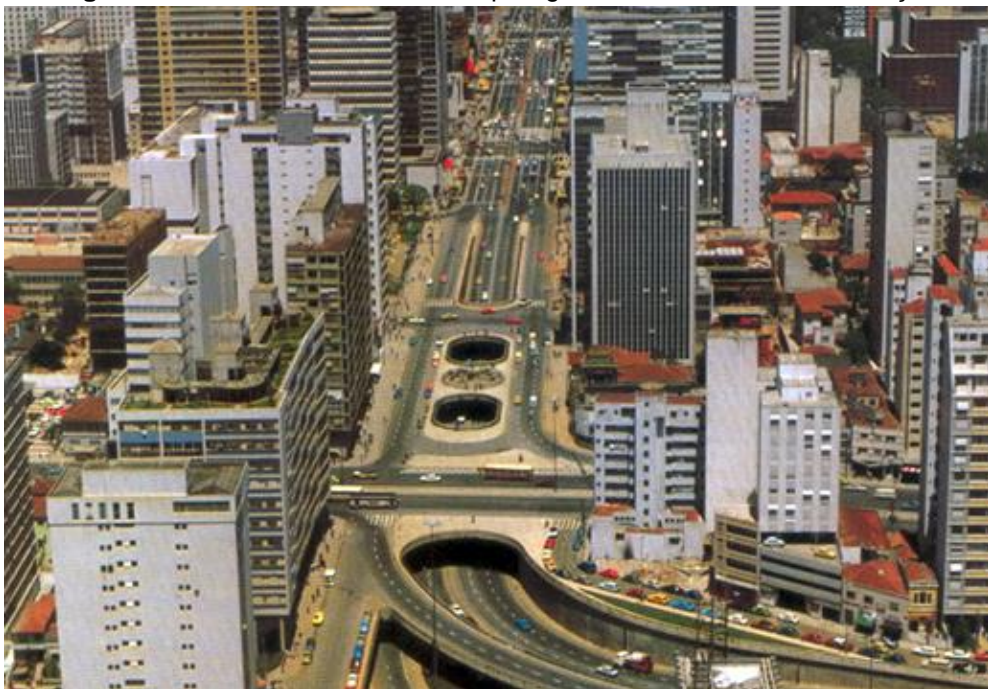
Figura 30: Visão aérea da do túnel que liga a Av. Paulista e a Consolação
